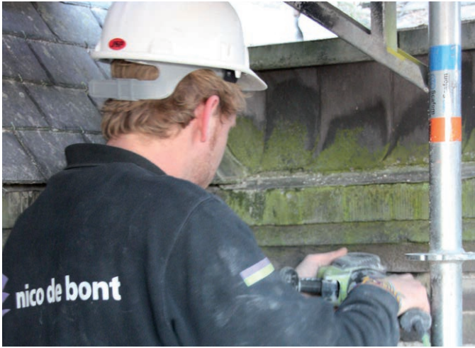
Bouwvakkersdorp: de restauratie van de Vughtse St.-Petruskerk (foto: Henk Smeets).
